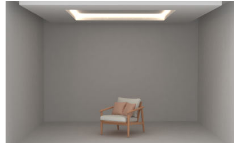
Veletta in cartongesso con illuminazione nella rientranza centrale del controsoffitto
