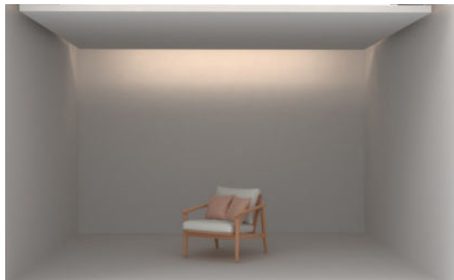
La struttura in ferro FRAME permette di illuminare in modo omogeneo e su tutta lunghezza le gole in cartongesso.
